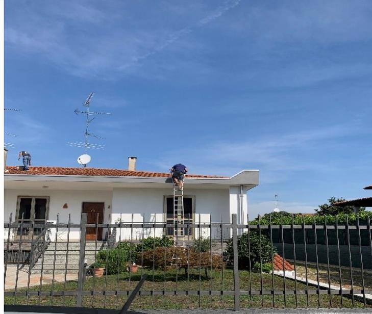
**19) Il candidato illustri sinteticamente le carenze in materia di salute e sicurezza desumibili dalla fotografia sottostante (profondità vano ascensore 1.5 metri), relativa ad un cantiere edile:**
